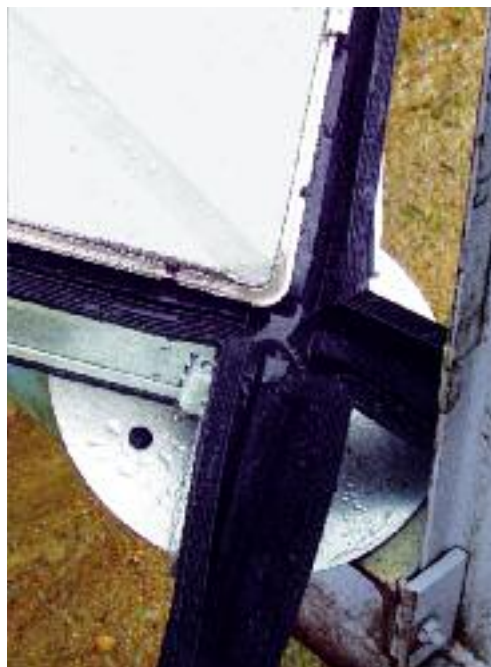
Fig. 17: Ytterpanelen av rostfritt stål hålls isolerad från den galvaniserade stålplåten på insidan med lämpligt utförda fogar.
