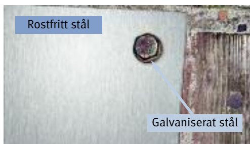
Fig. 10a, 10b: Praktiska exempel på principen som visas i Fig. 9 (galvaniserat kolstål i kontakt med rostfritt stål i marin atmosfär).
